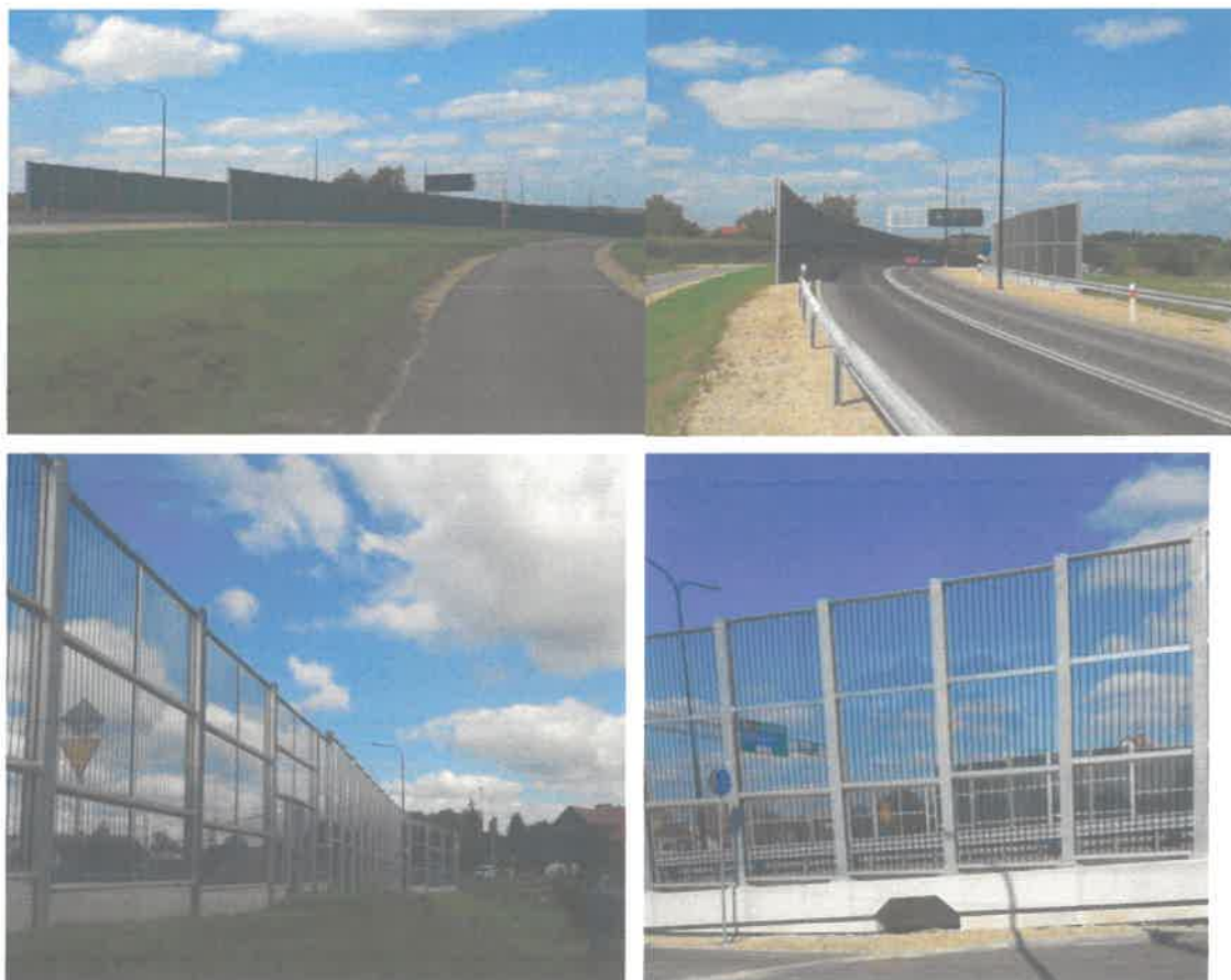
Rysunek 3-1 Zrealizowane zabezpieczenia akustyczne
